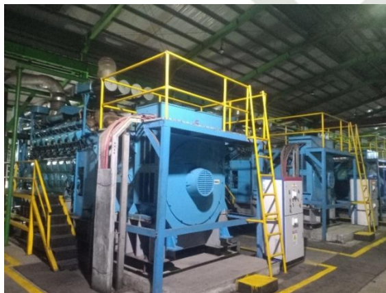
Gambar 2.1 Mesin Diesel Generator di PT IKPP perawang (Sumber : Dokumentasi Pribadi, 2024)
