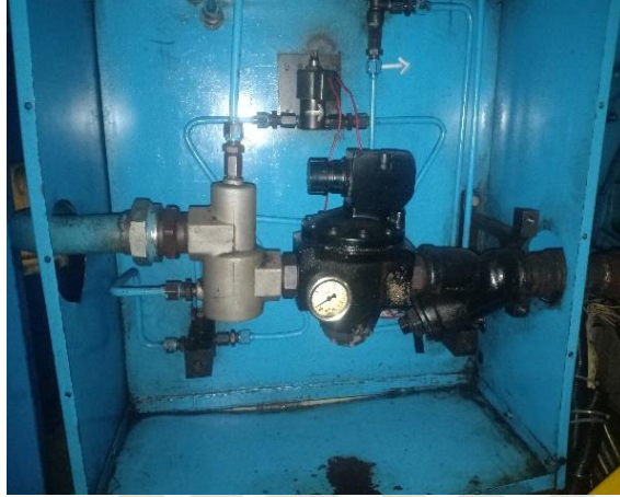
Gambar 2.5 Air Starting Valve (Sumber : Dokumentasi Pribadi, 2024)
