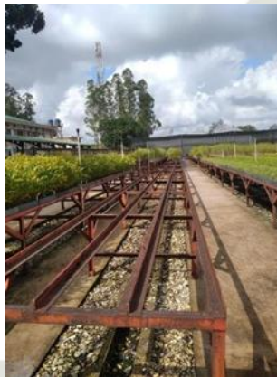
Gambar 3.1 Open Area di Nusery sebagai Area Penanaman
