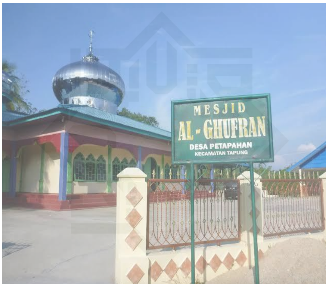
Dokumentasi masjid sebelum direnovasi
