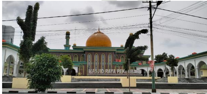
Gambar 3. 1 Tampak Depan Masjid Raya Pekanbaru
