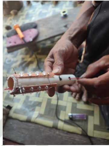
Penyambungan kabel lampu
