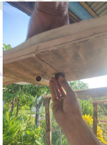
Pemasangan tutup lampu
