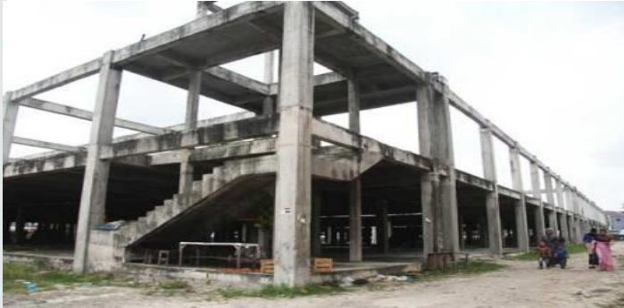
Gambar 1.1 Gedung Terbengkalai di Pasar Cik Puan
