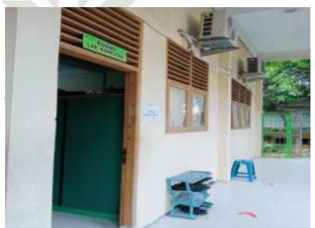
Ruang Laboratorium Komputer
