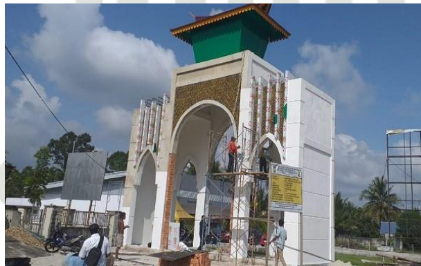
Pembangunan gapura batas kota di Salo
