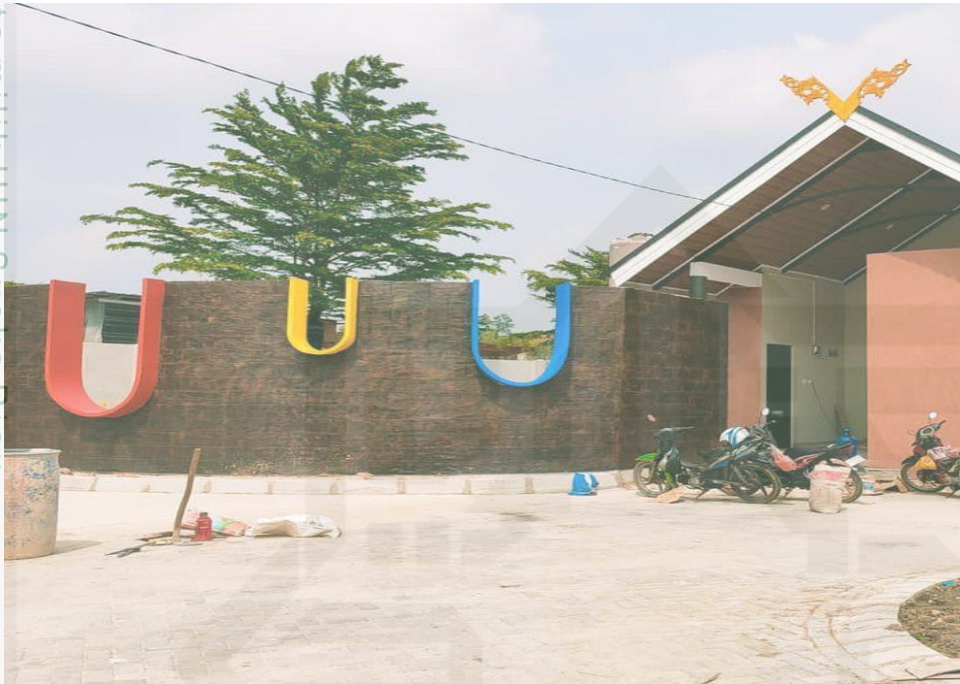
gambar 1. 33 Proses Pembangunan Preschool & Kindergarten
