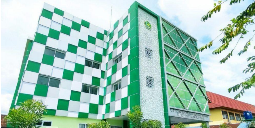
Gambar Gedung Olimpiade MAN 2 Kota Pekanbaru
