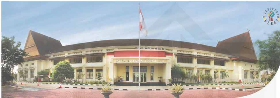
Gambar 4.1 Kantor Pusat PT Perkebunan Nusantara V Pekanbaru
