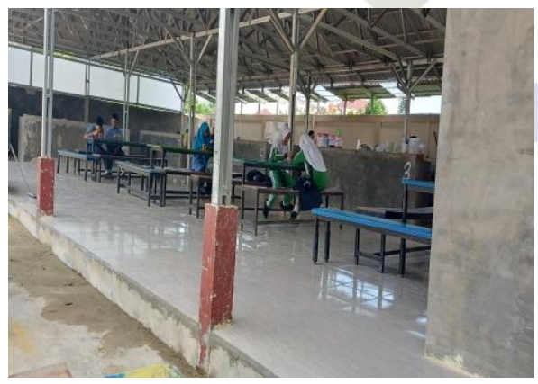
Kondisi kantin sekolah MTsN 3 Pekanbaru yg sedang direhab
