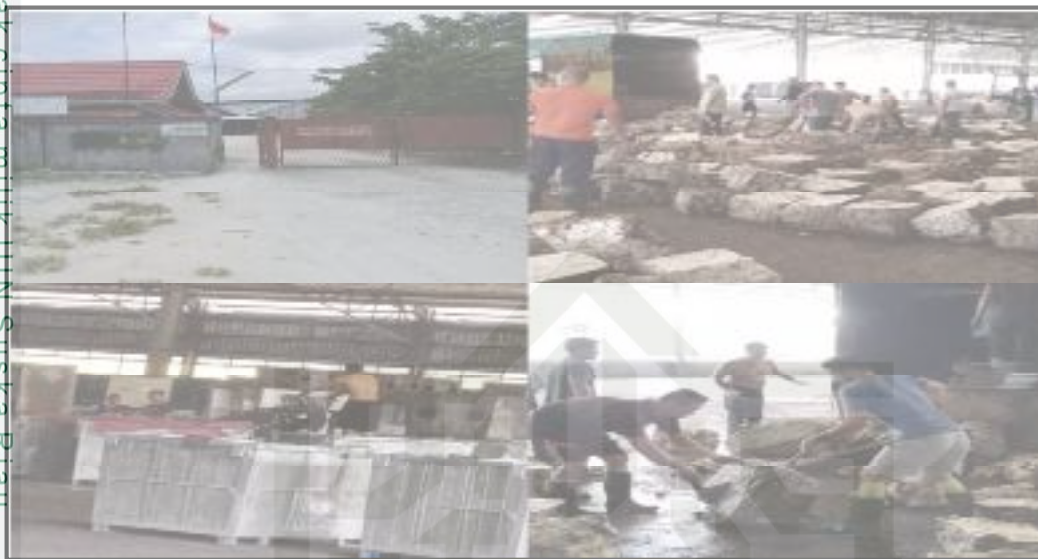
Gambar 1.1 Kondisi para pekerja saat berada di PT. Hervenia Kampar Lestari.
