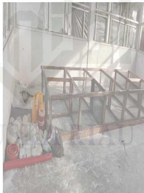
Gambar 4. Pemasangan sekat kandang
