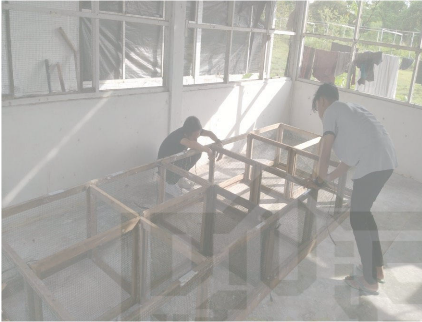
Pemasangan sekat kandang
