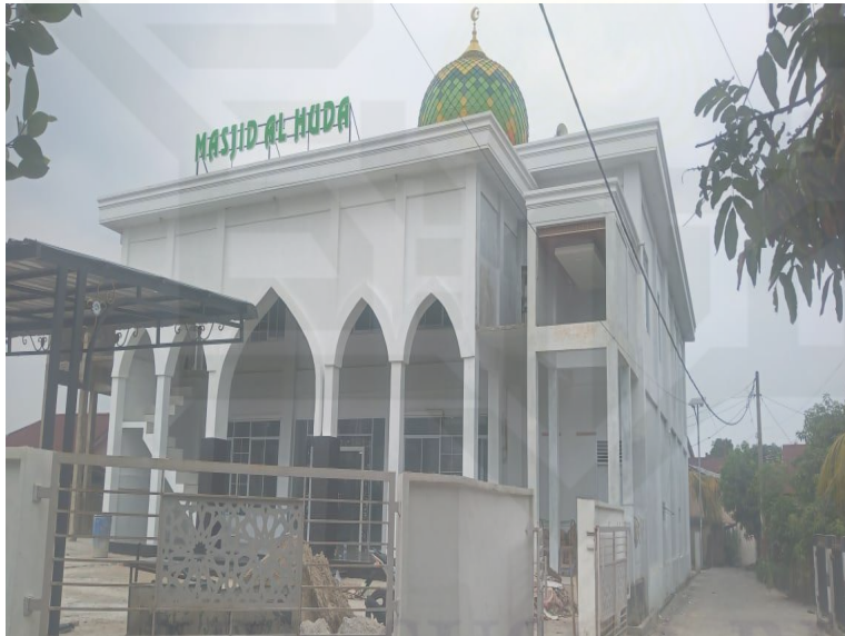
Dokumentasi Masjid Al-Huda Meperbaiki Sarana Prasarana
