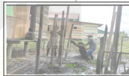
Gambar 17 pemancangan tanpa menggunakan alat (Sumber : Pengolahan Data 2022)
