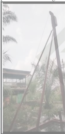
Gambar 16 alat pemancang (Sumber : Pengolahan Data 2022)
