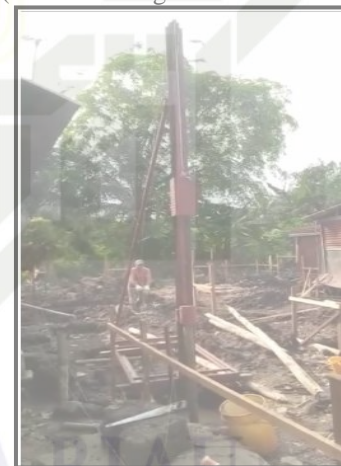
Gambar 18 pemancangan menggunakan alat (Sumber : Pengolahan Data 2023)
