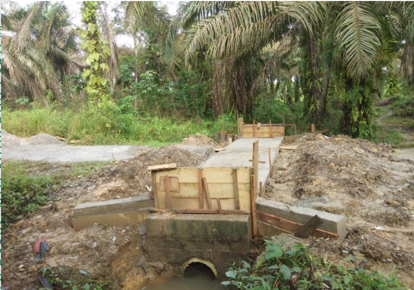
Pembangunan Box Culvert RT 03 RW 02 Dusun Setia
