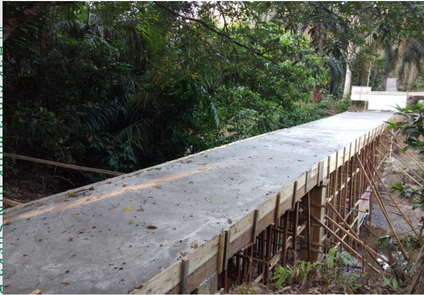
Pembangunan Jembatan RT 03 RW 01 Dusun Setia
