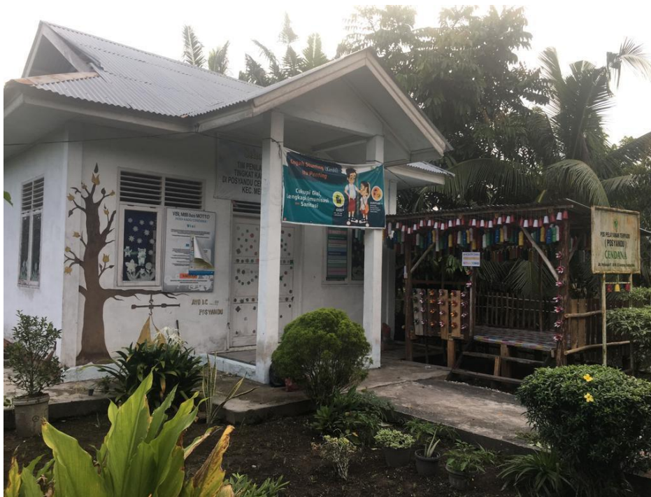
Dokumentasi gedung Posyandu Cendana
