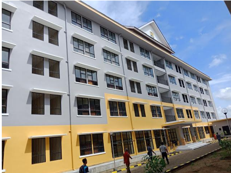
Gambar 4.5 Tampak Bangunan Hunian Rusunawa Sejuta Kanal
