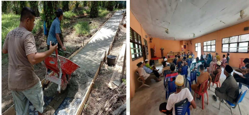
Gambar 4.2 Pelaksanaan Program Padat Karya Tunai (PKT) Pembangunan Jalan Tani sepanjang 500 x 1 Meter
