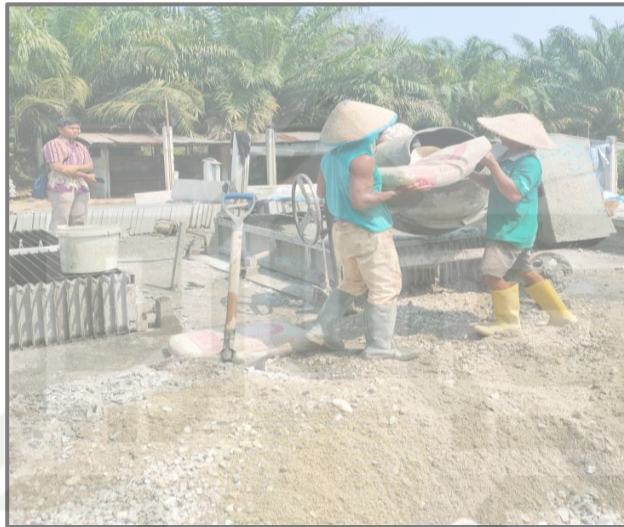
Gambar 1.1 Proses Mengangkat Semen
