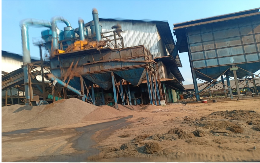
Gambar B.3. Kondisi Tempat Pengolahan PT. Inti Kamprindo Sejahtera
