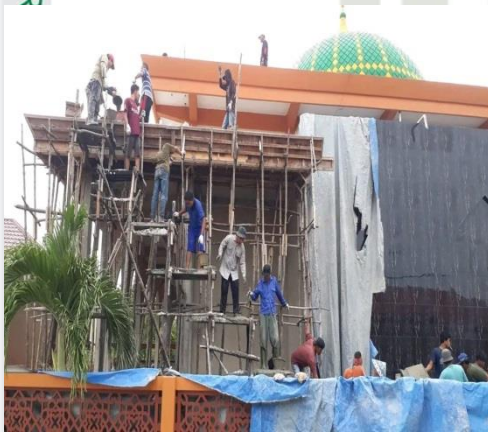
SKR Dokumentasi pembangunan Masjid
