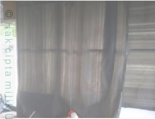
Pemasangan Tirai Kandang
