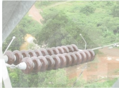
Gambar 2.13 Isolator Keramik[29]
