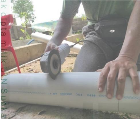
Gambar 1. Pemotongan Pipa
