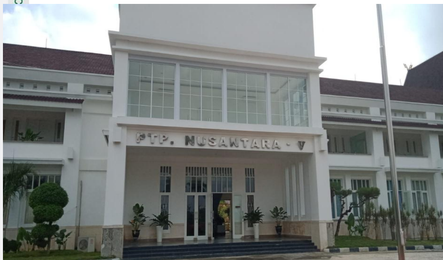
Kantor direksi PT. Perkebunan Nusantara V (Persero) yang terletak di Jl. Rambutan No. 43, Sidomulyo Timur, Kecamatan Marpoyan Damai, Kota Pekanbaru, Riau, Kode Pos 28289, Indonesia.
