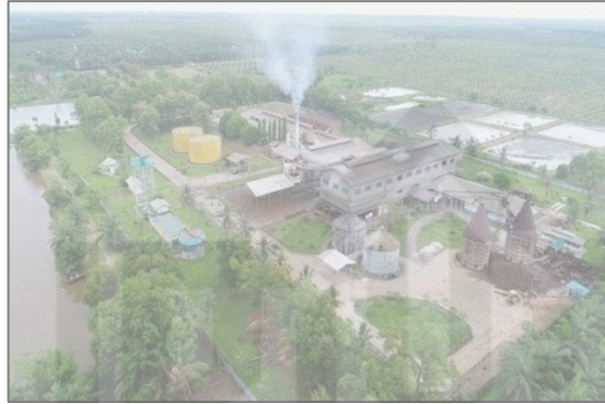
Gambar 1.1 Pabrik Kelapa Sawit Sungai Dua
