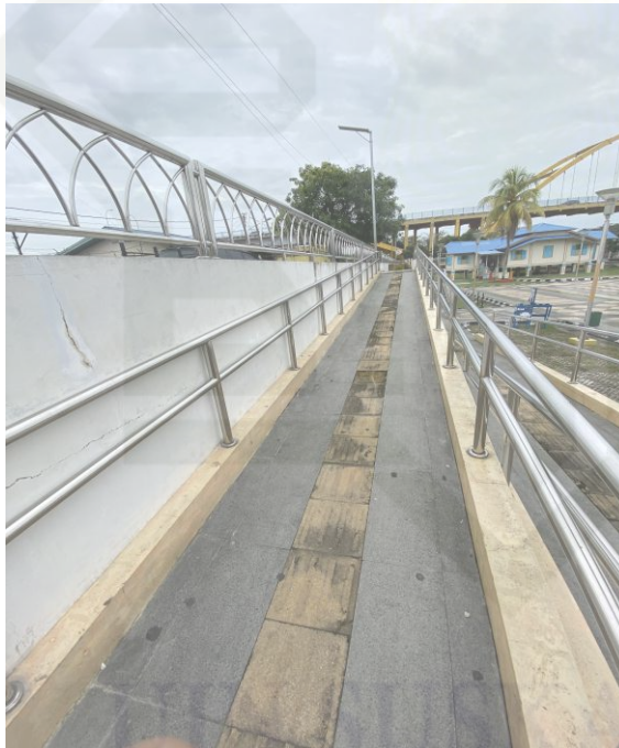
Jalur pemandu dilengkapi ramp di jalan masuk Rumah Singgah Tuan Kadi
