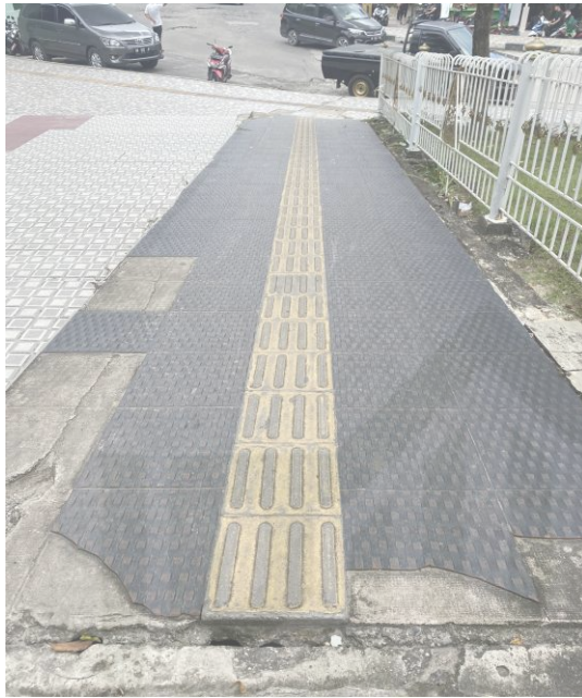
Jalur pemandu dilengkapi ramp di jalan masuk RTH Tunjuk Ajar Integritas
