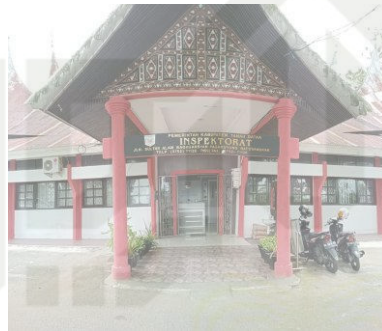
Gambar 3. Kantor Inspektorat Kabupaten Tanah Datar
