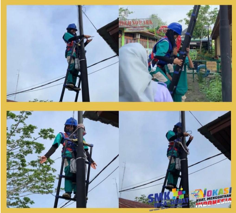
Pemasangan wifi oleh teknisi TKJ
