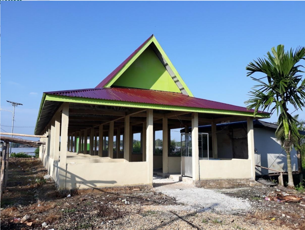
Pembangunan Infrastruktur Pasar Desa
