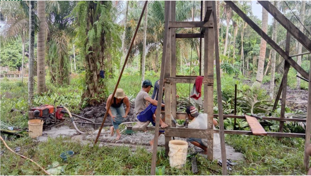
Pembuatan Sumur Bor
