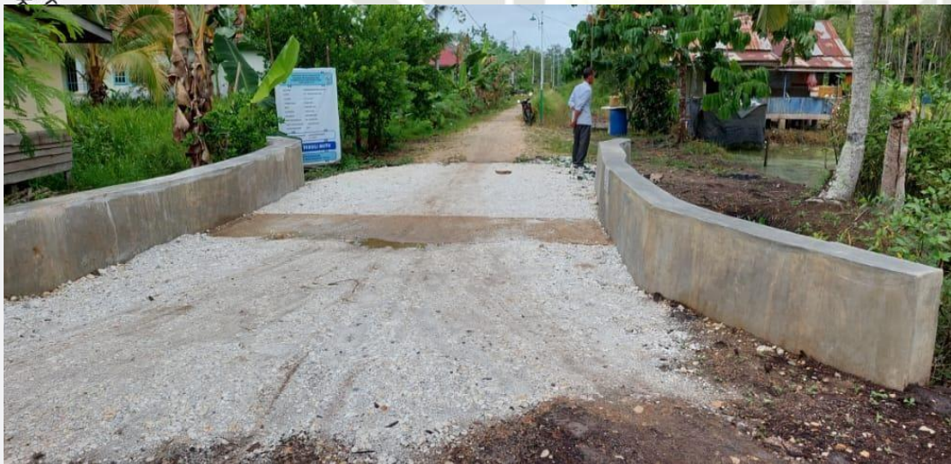
Pembangunan Box Culvet
