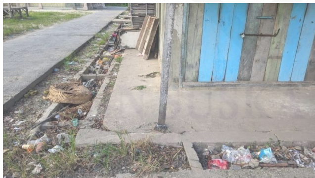
Gambar 12) Kondisi drainase di Dusun III Pasar Rumbio
