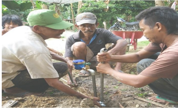
Gambar 9) Proses pemasangan pipa di rumah warga
