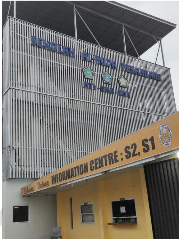
Gedung Utama SMA Al-Huda Pekanbaru
