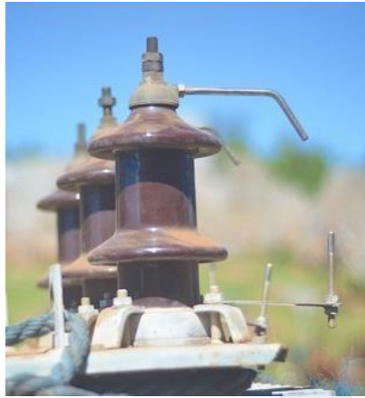
Gambar 2. 14 Arching horn pada bushing [10]
