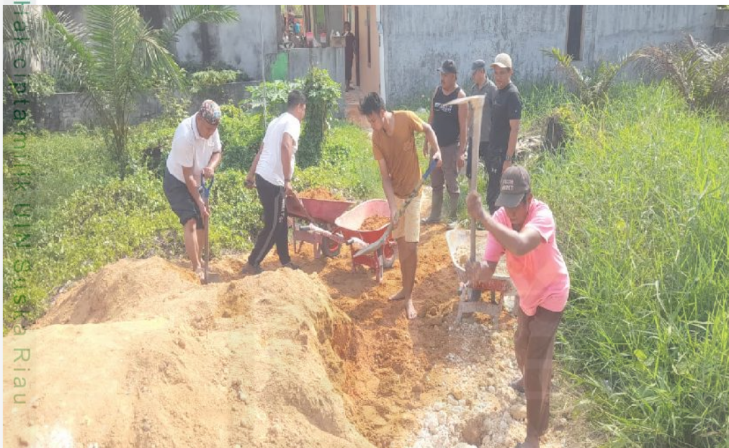
GAMBAR 1.14 Suasana Gotong Royong jama'ah untuk menimbun pondasi pembangunan toilet di Masjid Nurush Shadri
