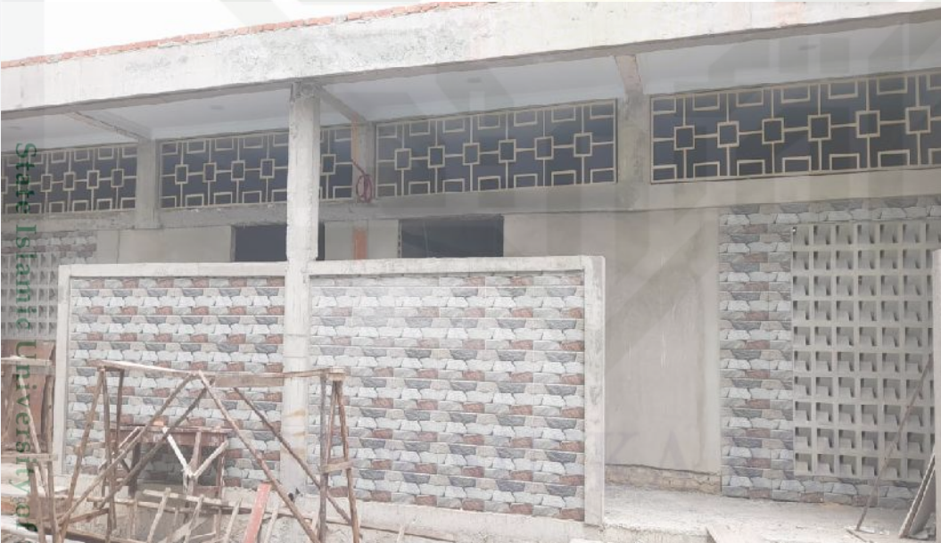
GAMBAR 1.16 Proses pembangunan toilet di Masjid Nurush Shadri sudah mencapai 80 %
