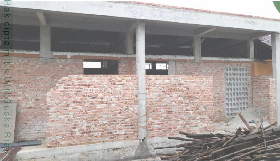
GAMBAR 1.16 Proses pembangunan toilet di Masjid Nurush Shadri sudah mencapai 60 %
