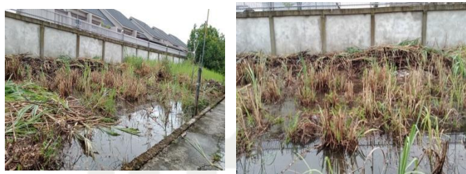
Gambar 3.1. Pembersihan Lahan Sumber: dokumentasi penelitian 2021
