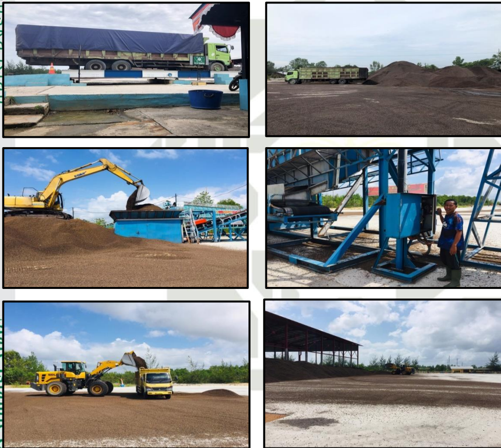
Gambar 1.1 Stasiun Proses (Sumber. PT. Jatim Propertindo Jaya)
