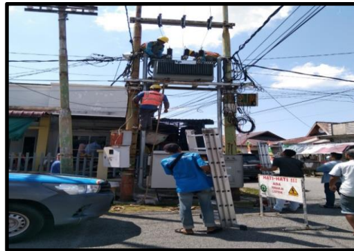
Perbaikan jaringan listrik
