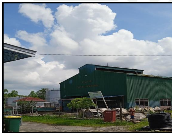
Sumber : PT. PLN (Persero) ULP Selatpanjang
