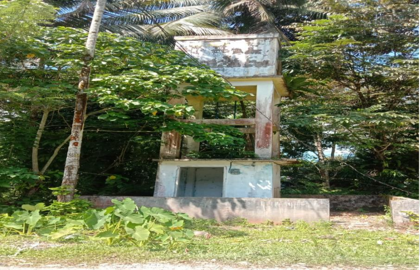
Sumur bor Desa Pulau Binjai
