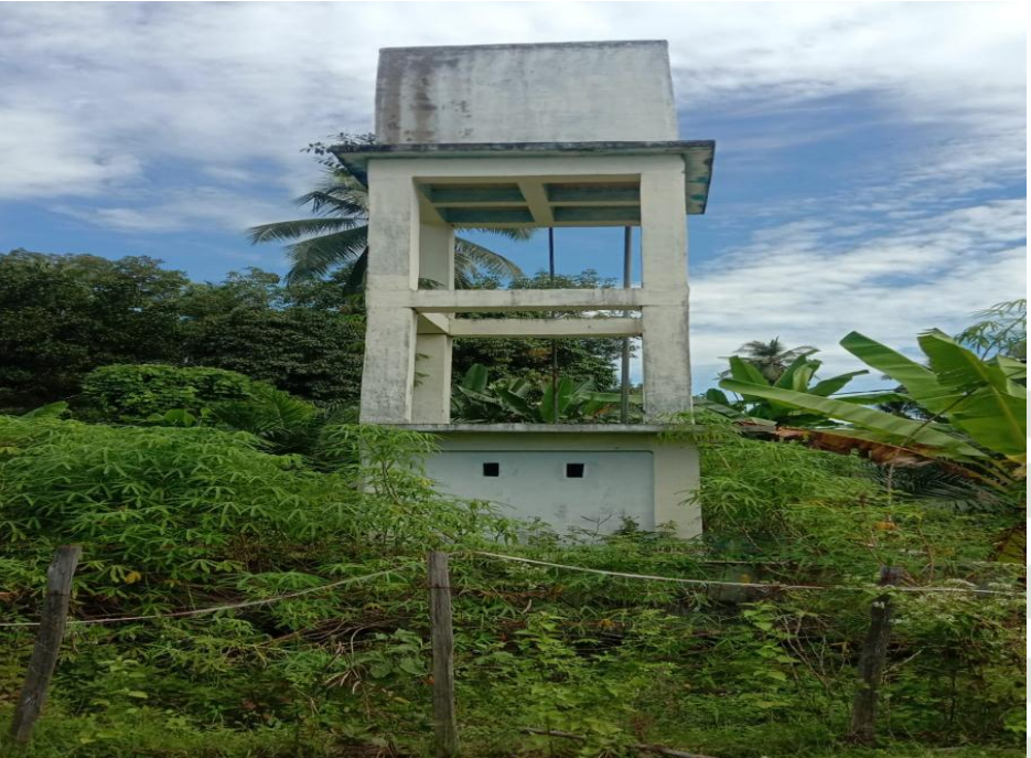
Sumur Bor Desa Saik
