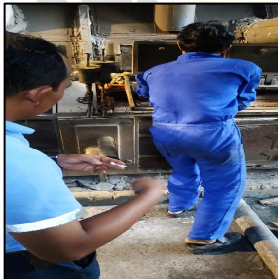
Gambar 4.1 Proses Pekerjaan di Area Refinery (Sumber: Pengumpulan Data, 2020)
