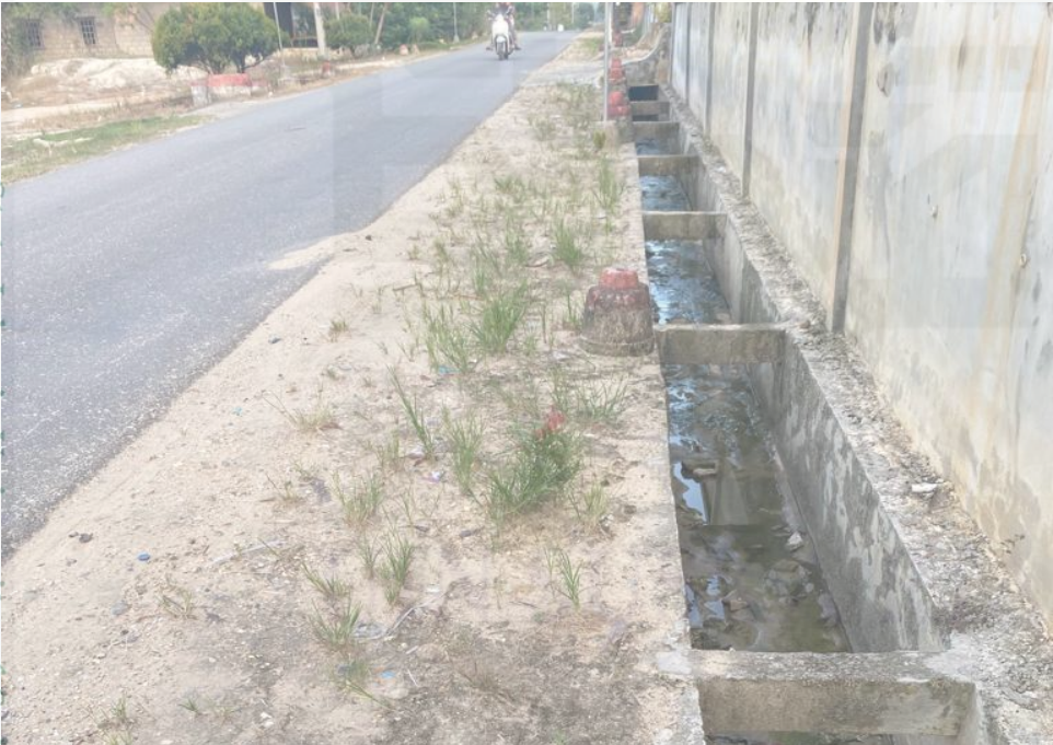
Drainase di Jalan Poros Bukit Kemuning
