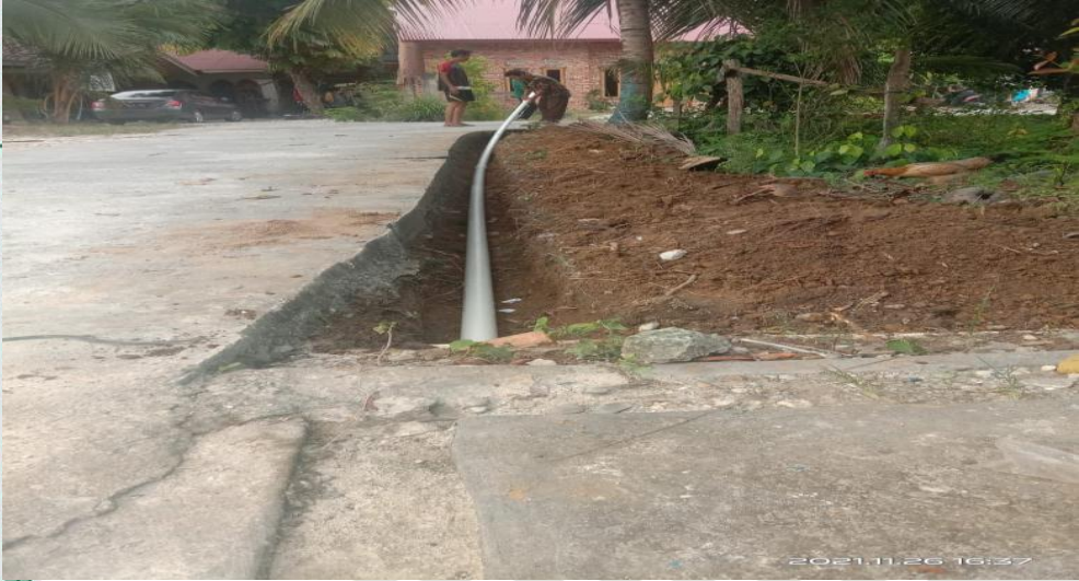
Dokumentasi memperbaiki pipa air pamsimas
