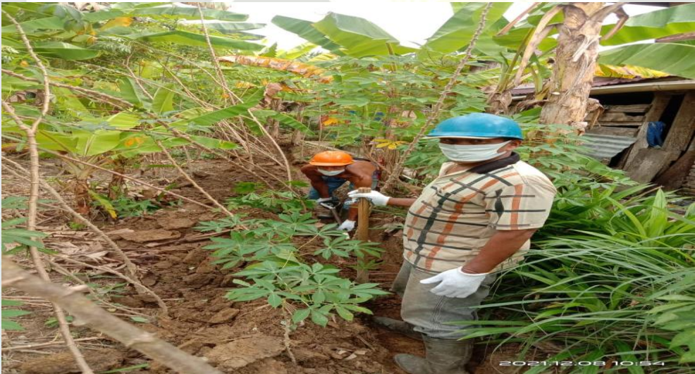
Dokumentasi pembuatan jalur pipa baru pamsimas
