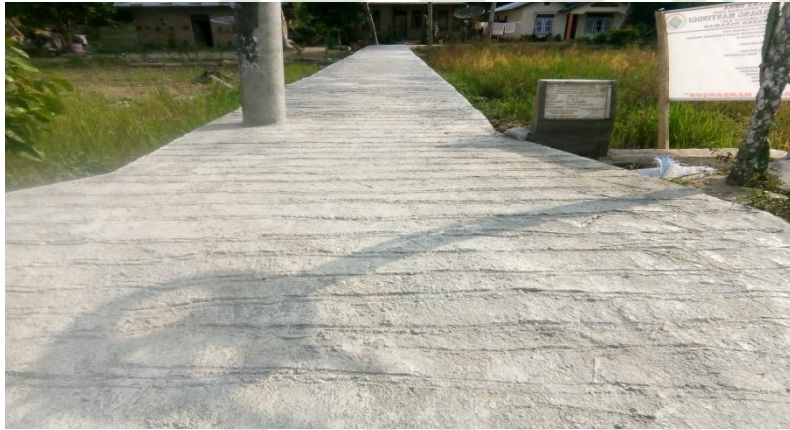
Pembangunan jalan lingkar Kampung Panden
