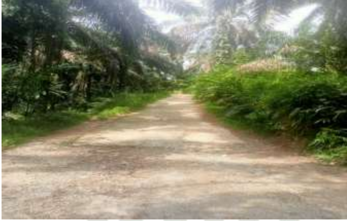
Gambar pembangunan Jalan ke Lahan Perkebunan atau Pertanian masyarakat Desa
