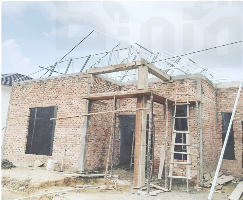
Gambar B.2. Pembangunan Rumah 2
