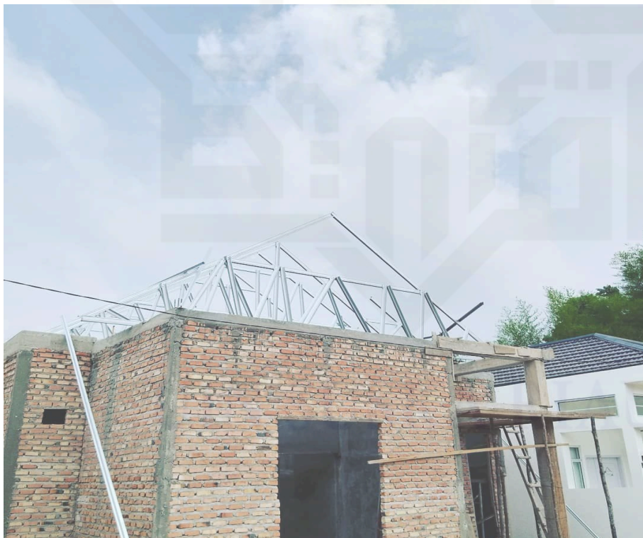
Gambar B.4. Pembangunan Rumah 4
