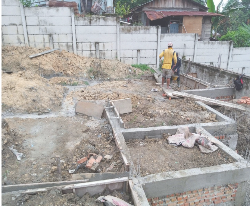
Gambar B.1. Pembangunan Rumah 1
