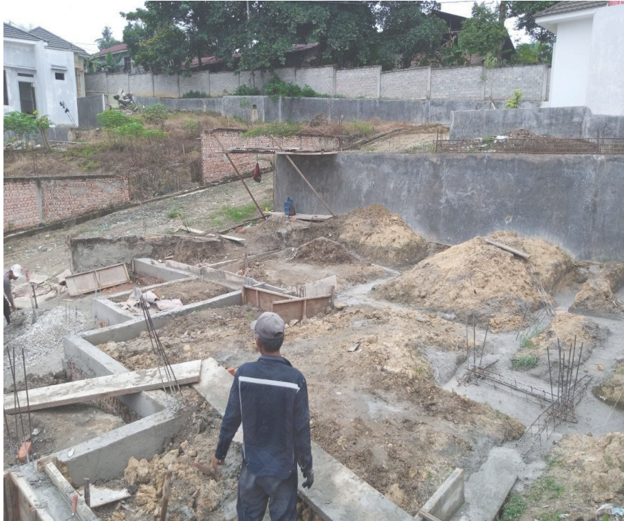
Gambar B.3. Pembangunan Rumah 3
