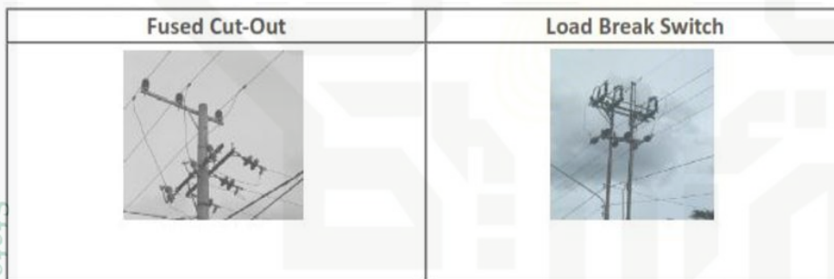
Gambar 2.12 Letak Pemasangan FCO dan LBS
