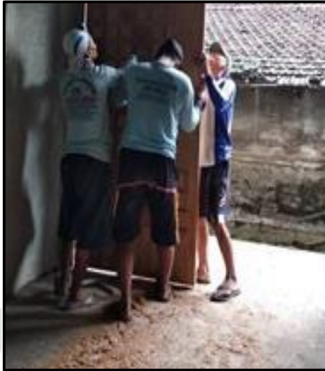
Gambar 1.1 Pemasangan Daun Pintu (Sumber: Proyek Rumahan)
