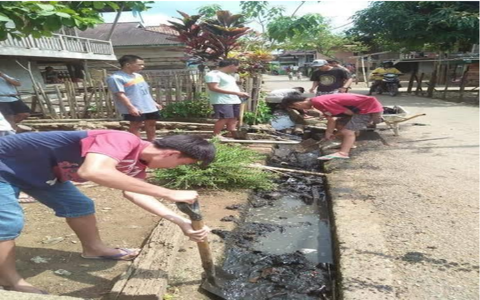
(gotong royong membersihkan selokan)
